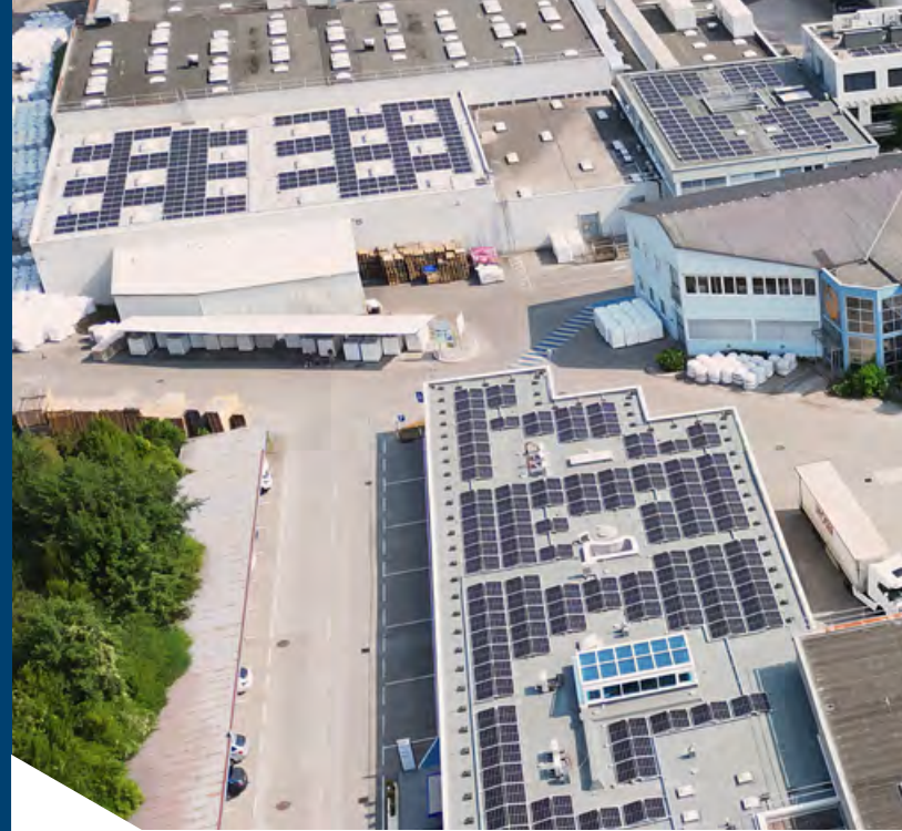
Photovoltaikanlagen am Standort Kremsmünster
